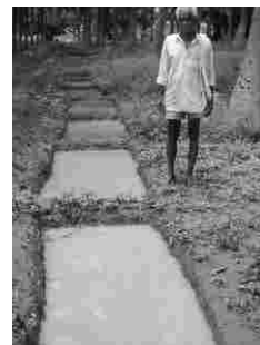
Trench cum bund
